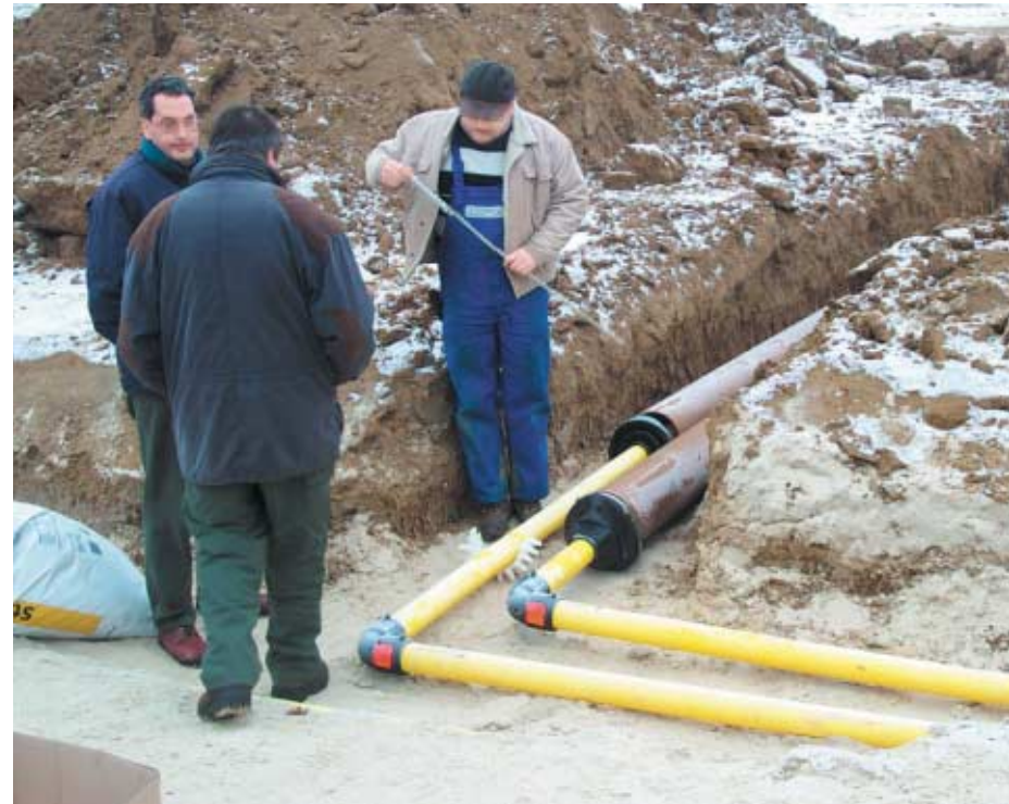
Verlegung der Gassammelleitungen
