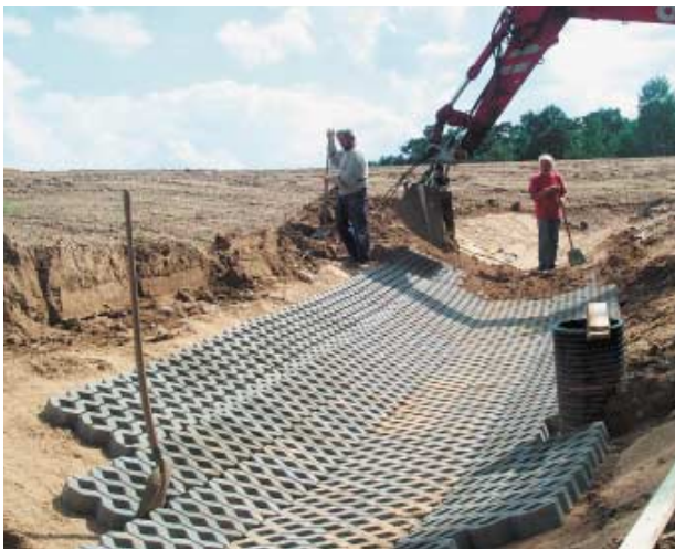
Auslegen des Randgrabens mit Rasengittersteinen
