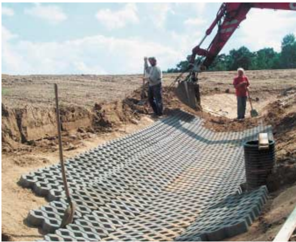
Auslegen des Randgrabens mit Rasengittersteinen
