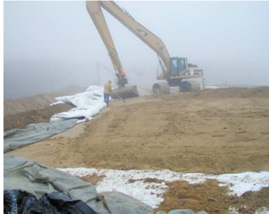
Arbeiten auch bei ungünstigen Witterungsbedingungen
