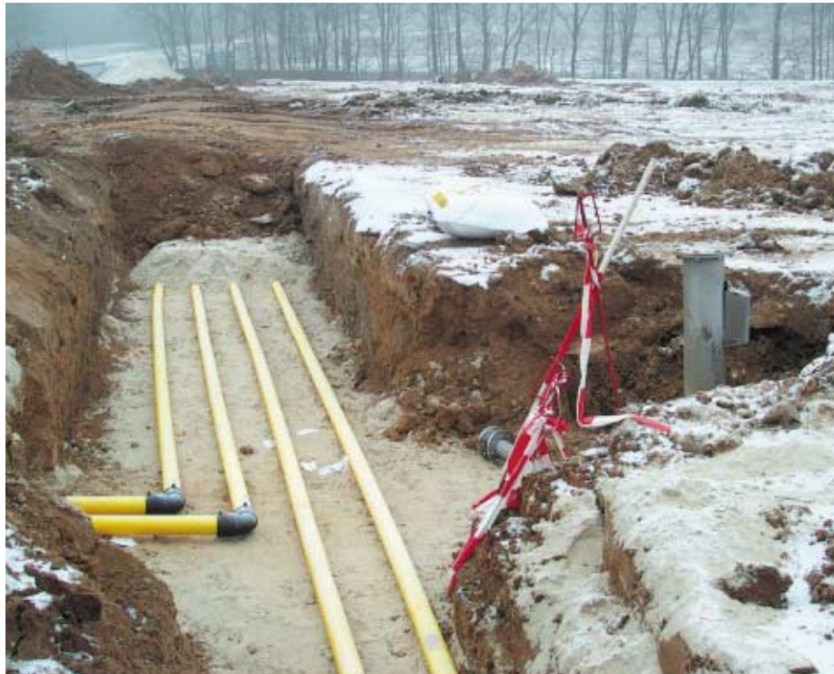
Verlegung der Gassammelleitungen
