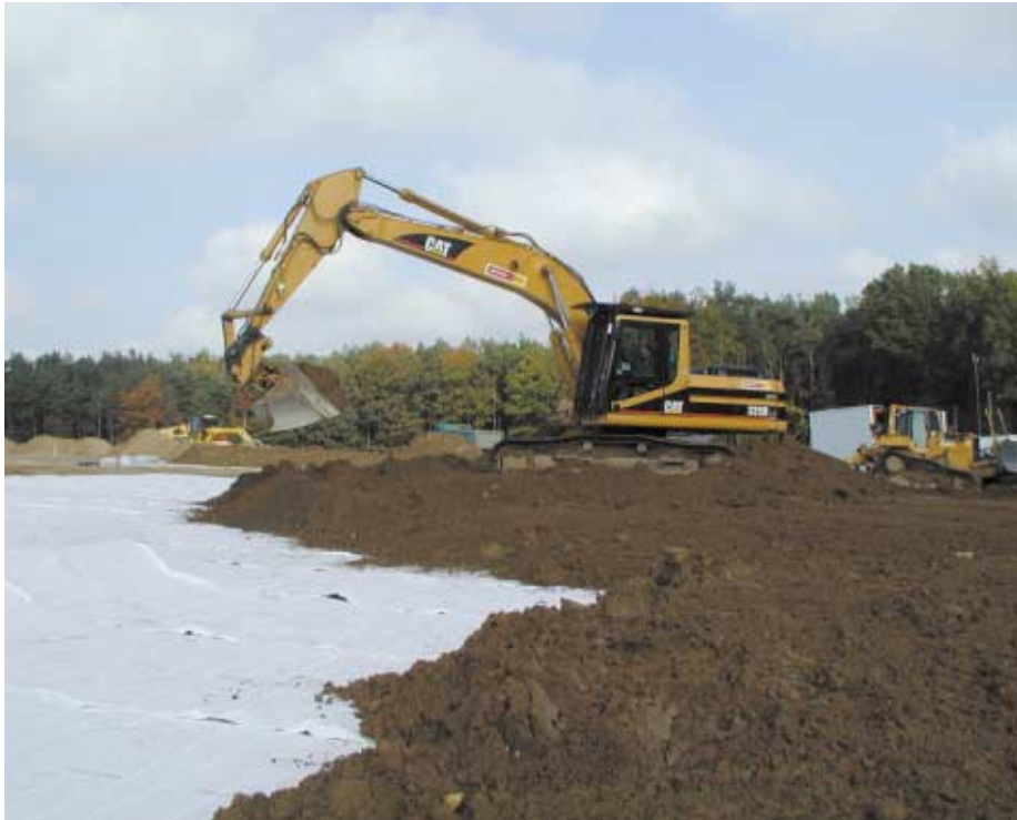
Einbau des Rekultivierungsbodens
