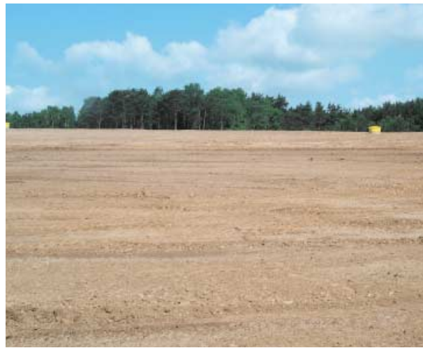
fertige Oberflächenprofilierung vor Anspritzbegrünung
