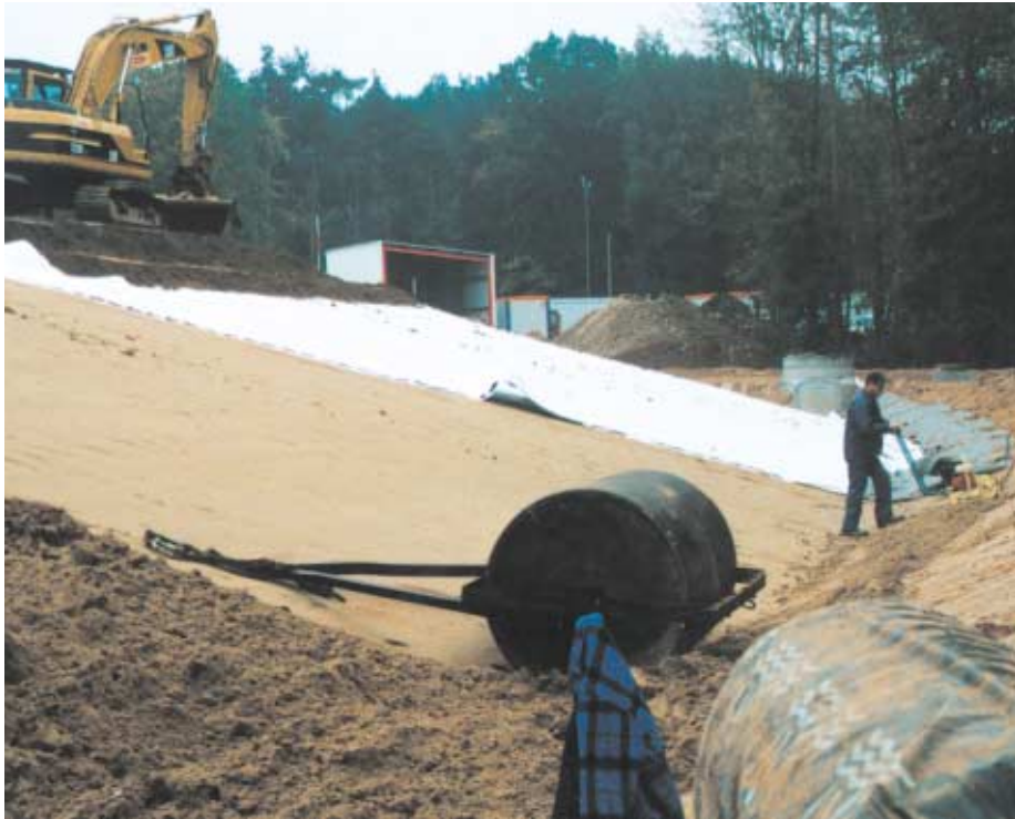
Arbeiten im Deponierandbereich
