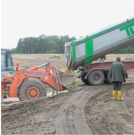
Anlieferung Trisoplast auf der Deponie
