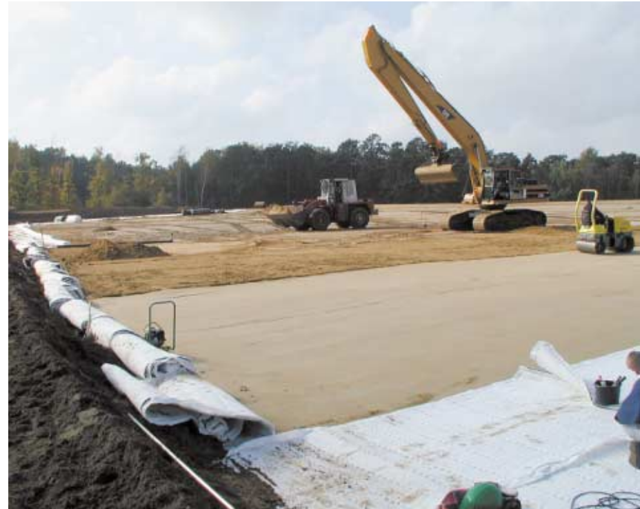
Abwalzen von Trisoplast mit Tandemwalze vor Aufbringen der Dränmatte
