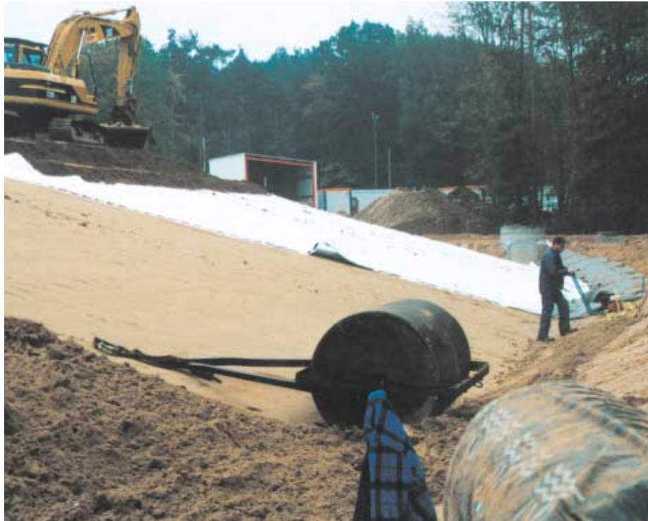
Arbeiten im Deponierandbereich
