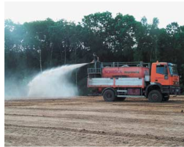
Durchführung der Anspritzbegrünung
