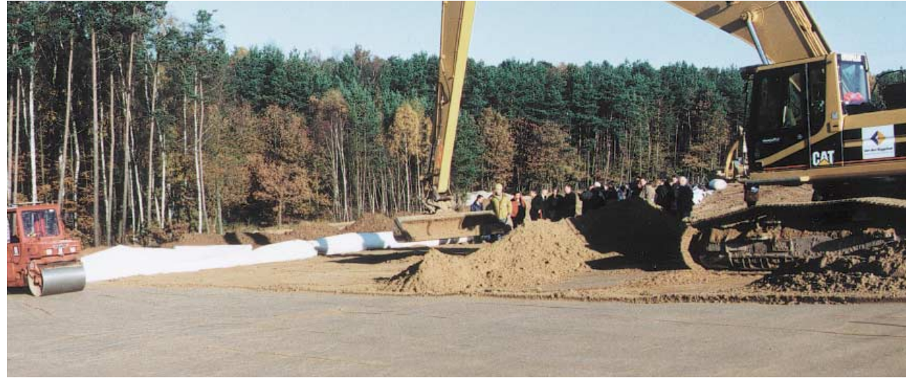
Einbau von Trisoplast während der Fachtagung
